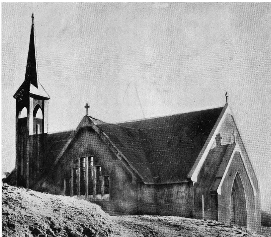
Ajoutons, pour être complet, que la construction est faite en béton armé sur charpente métallique fabriquée par la Maison Robert, d'Alger. La toiture est à forte inclinaison pour permettre le glissement de la neige, et la flèche ajourée peut recevoir une ou plusieurs cloches. Le jour entre abondamment à l'intérieur de l'édifice, par de grandes verrières. Seul le gros œuvre est actuellement achevé ; il reste à faire le plafond, ainsi que toute la décoration intérieure.
